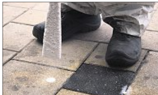
Die kalte Luft wird mit acht Bar Druck aufs Pflaster geblasen, sodass sich das Kaugummi zusammenzieht und brüchig wird. Köhler
