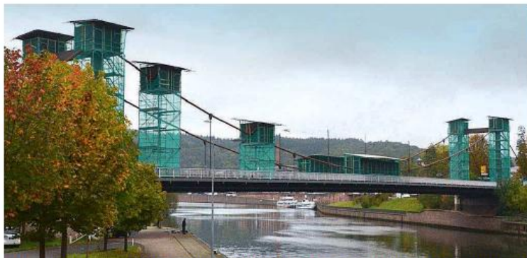
Zum Schutz für Anwohner, Verkehrsteilnehmer und Umwelt sind derzeit die Arbeitsbühnen an der Mettlacher Brücke sicher umhüllt. FOTOS: NORBERT WAGNER
