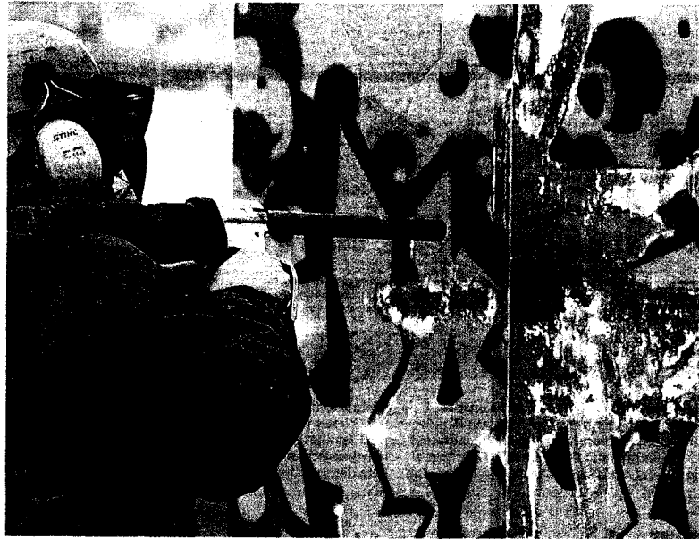
Mit Trockeneis wird Graffiti schonender von Hauswänden entfernt als mit dem Sandstrahler.
