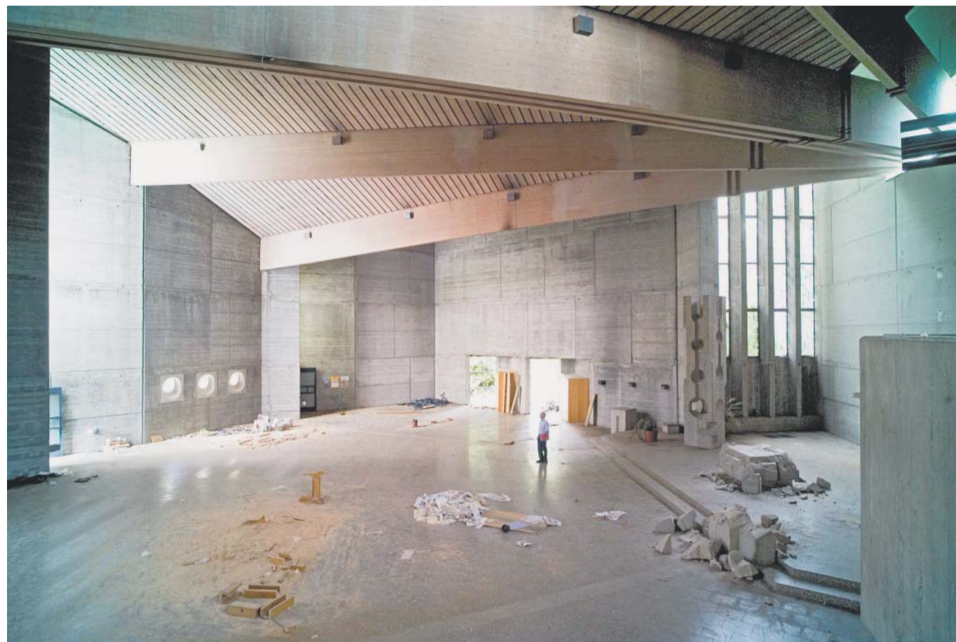
Leerstand: Für die Auferstehungskirche gibt es keine Zukunft mehr. Die Sanierung käme zu teuer.
